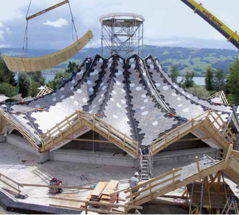
▲ 24 Elemente mit je 4 Tonnen Gewicht wurden so montiert, dass sie ein Faltragwerk bilden
