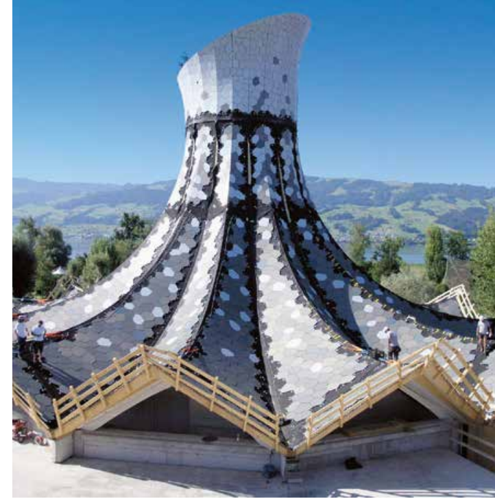
▲ Das freitragende Dach wird von unregelmäßig geformten Blechschuppen bedeckt
