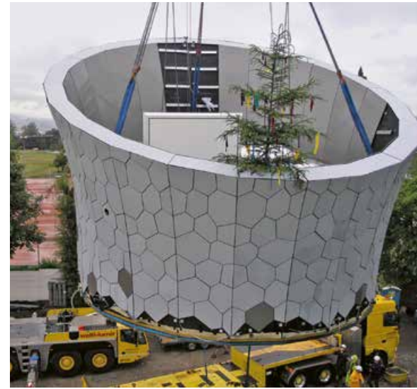
▲ Der 19,8 Tonnen schwere „Hut“ wurde als Sonderelement mit dem Kran in Position gebracht
